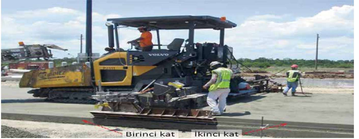
Resim 4. Yüksek Sıkıştırma Özelliğine Sahip 2 Finaşer ile “Yaş Üzerine Yaş” ( “Wet to wet” ) Çift Katman YSB Uygulamasından Bir Görünüm [8] [8]
