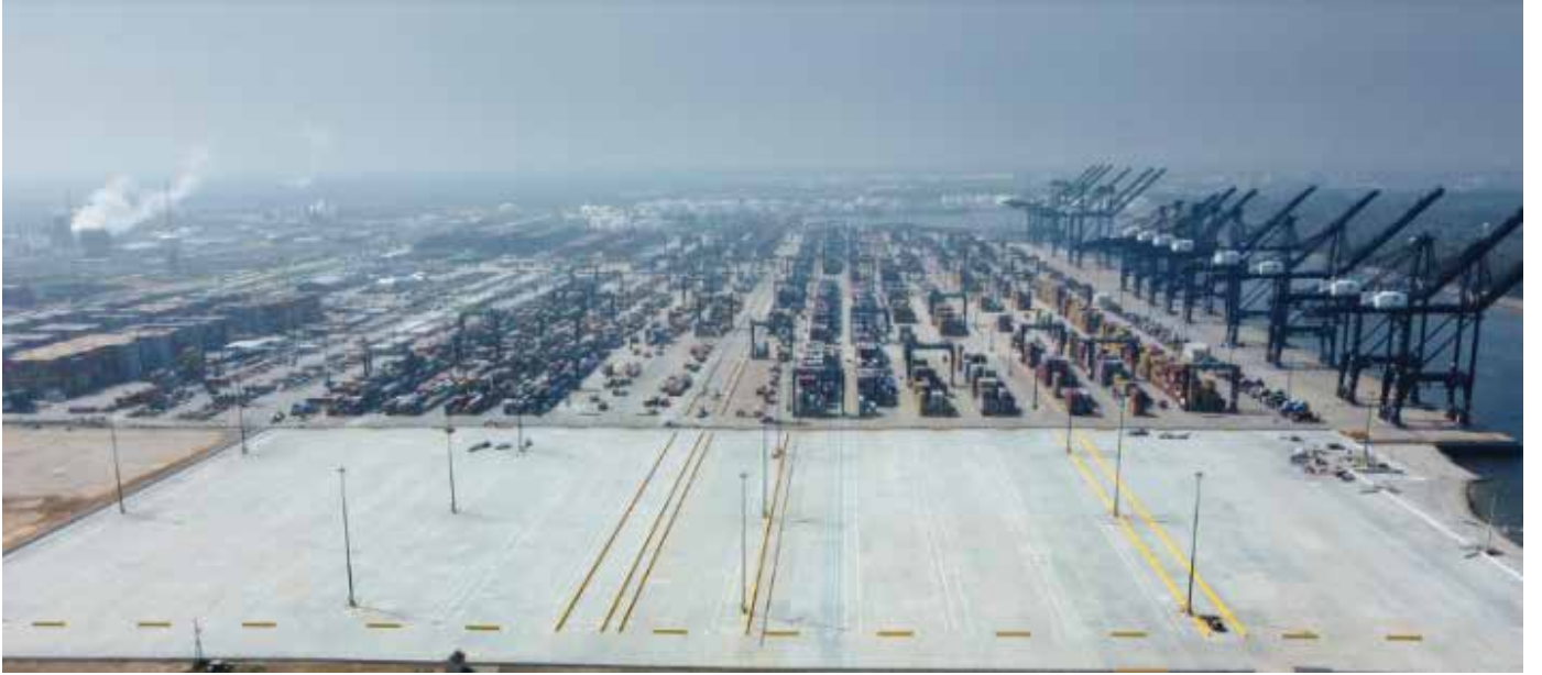
Resim 3. Port Houston'daki Yüksek Sıkıştırılmış Beton (YSB) Kaplanmış Sahadan Bir Görünüm [6]
